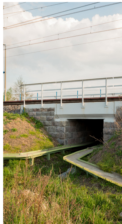
Wyremontowany przepust w Borszewicach
