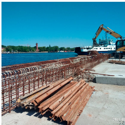
Prace zbrojarskie na nabrzeżu
