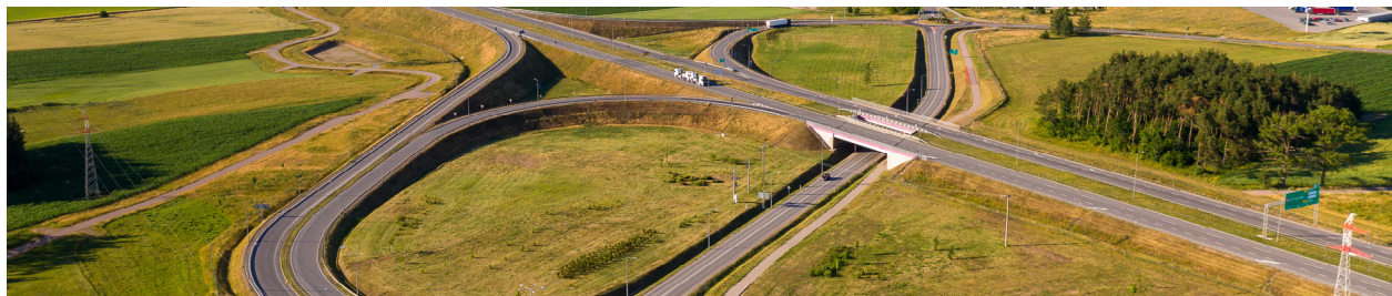
Węzeł na obwodnicy Suwałk
