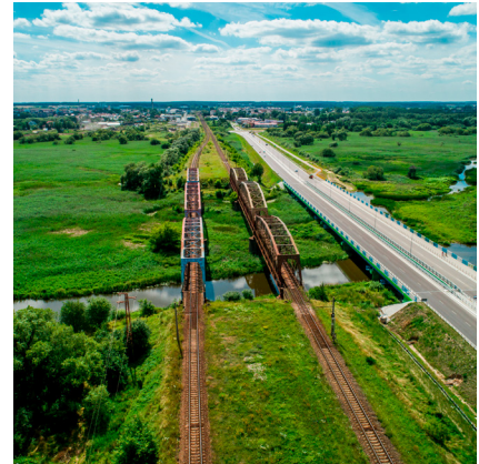
Most na rzece Narew, stan sprzed realizacji
