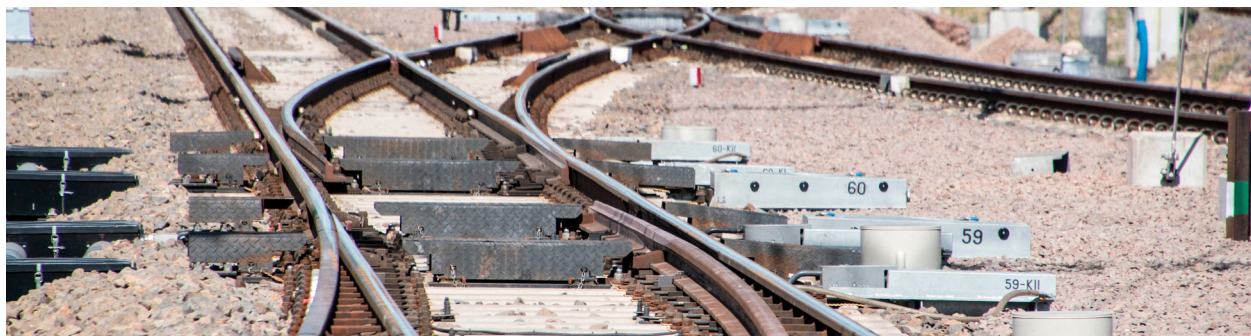
Nowe rozjazdy na stacji Konin
