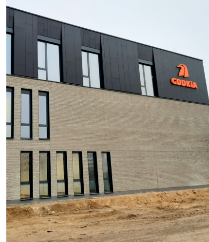
Budynek Krajowego Centrum Zarządzania Ruchem
