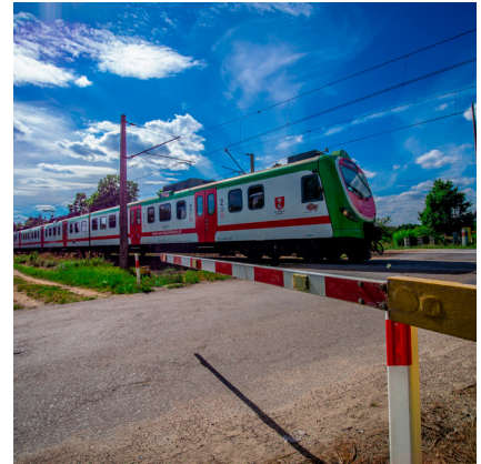
Przejazd w Trypuciach, stan sprzed realizacji
