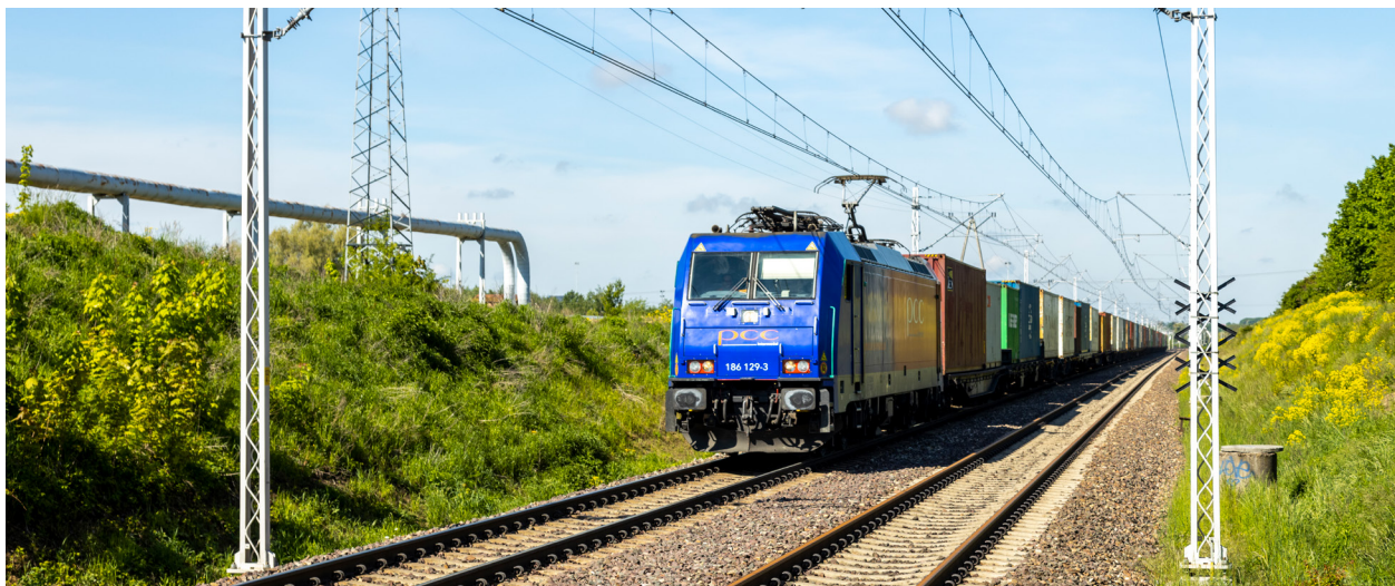
Wyremontowana infrastruktura w okolicach Kutna
