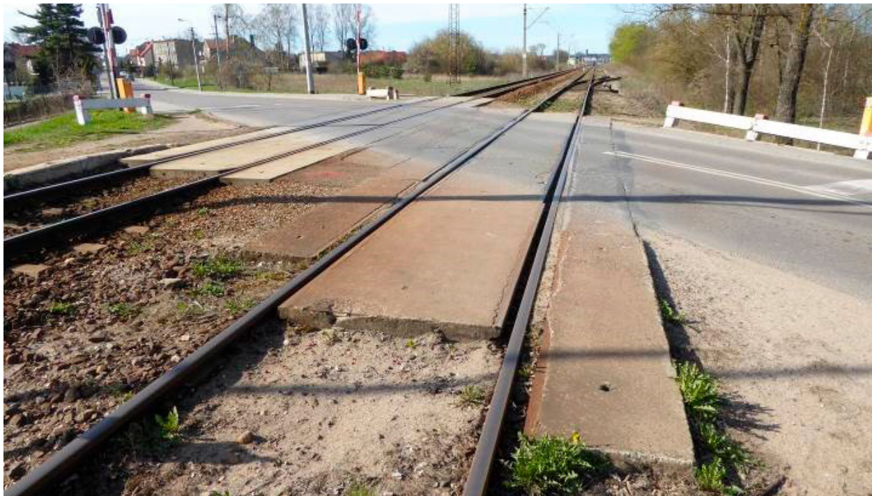
Przejazd przez tory na terenie Ełku, stan sprzed realizacji
