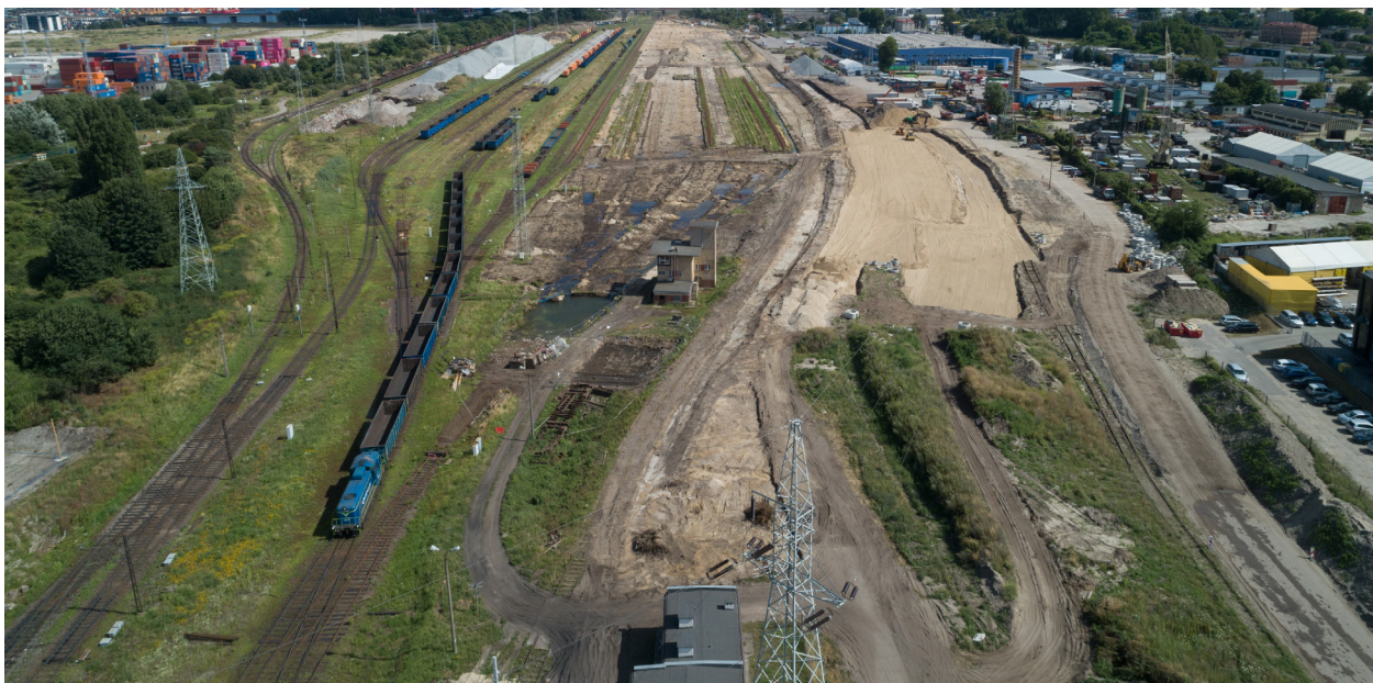
Stacja Gdynia Port, w trakcie realizacji
