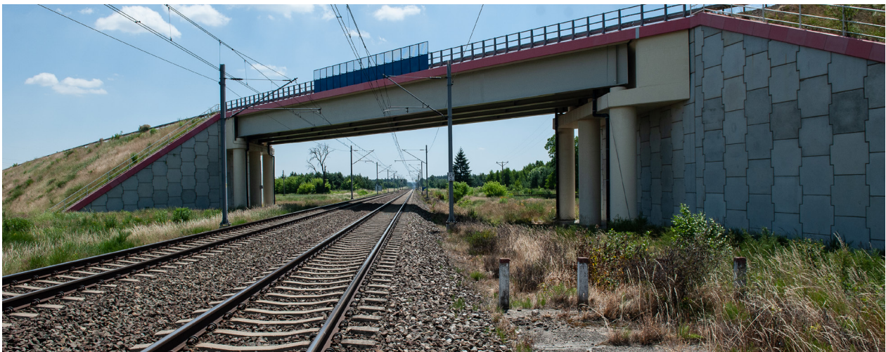
Wybudowany wiadukt drogowy nad CMK
