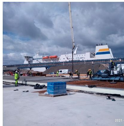
Prace na nawierzchni placu D
