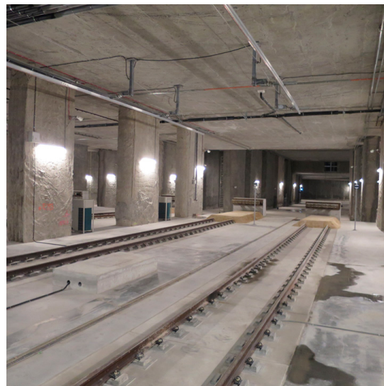
Zakończenie istniejącego tunelu konwencjonalnego
