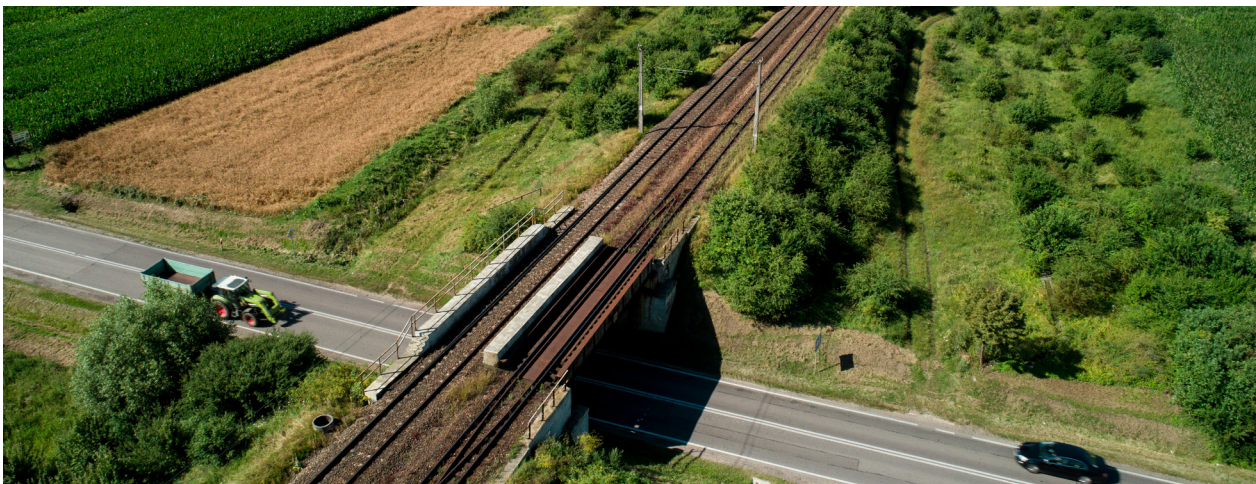
Wiadukt w okolicy Czyżewa, stan sprzed realizacji
