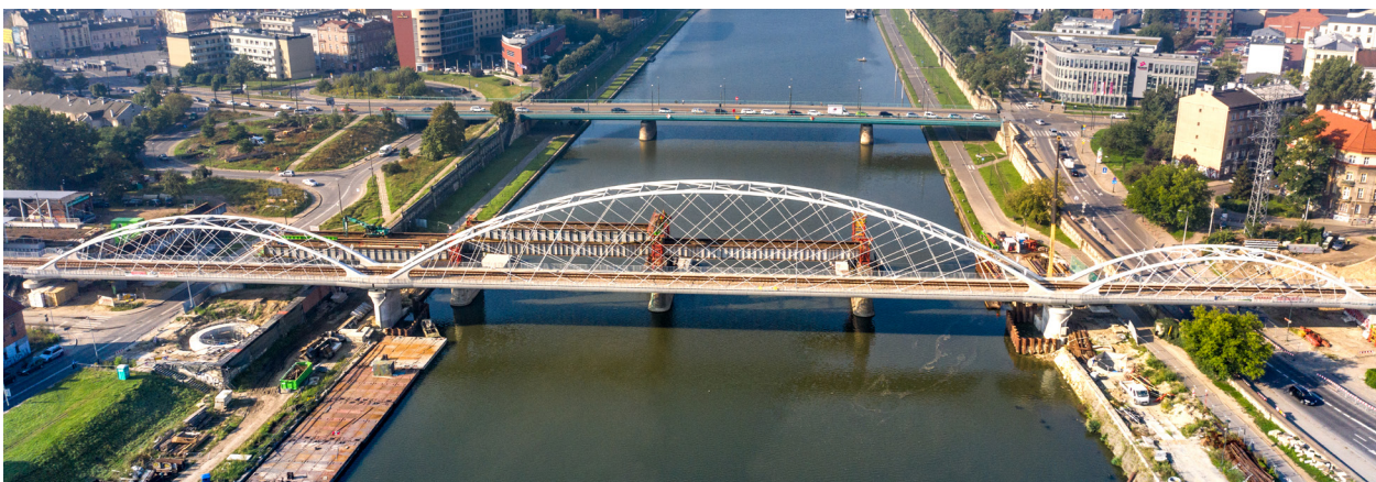
Budowa nowego mostu na Wiśle
