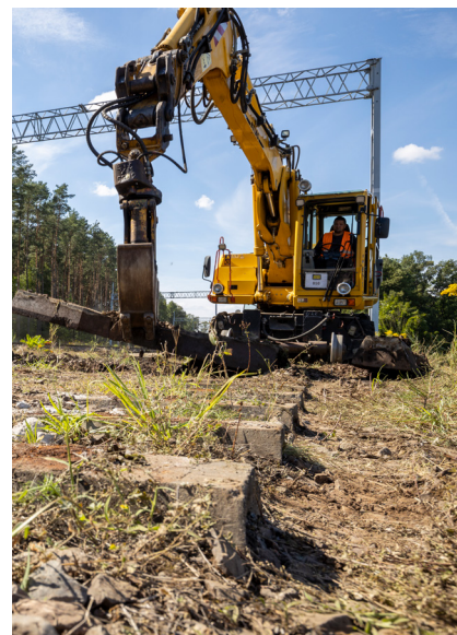
Prace w rejonie Podleśca
