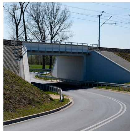
Zrealizowany wiadukt Widziszewo
