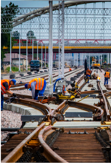
Gdańsk Zaspa Towarowa station
