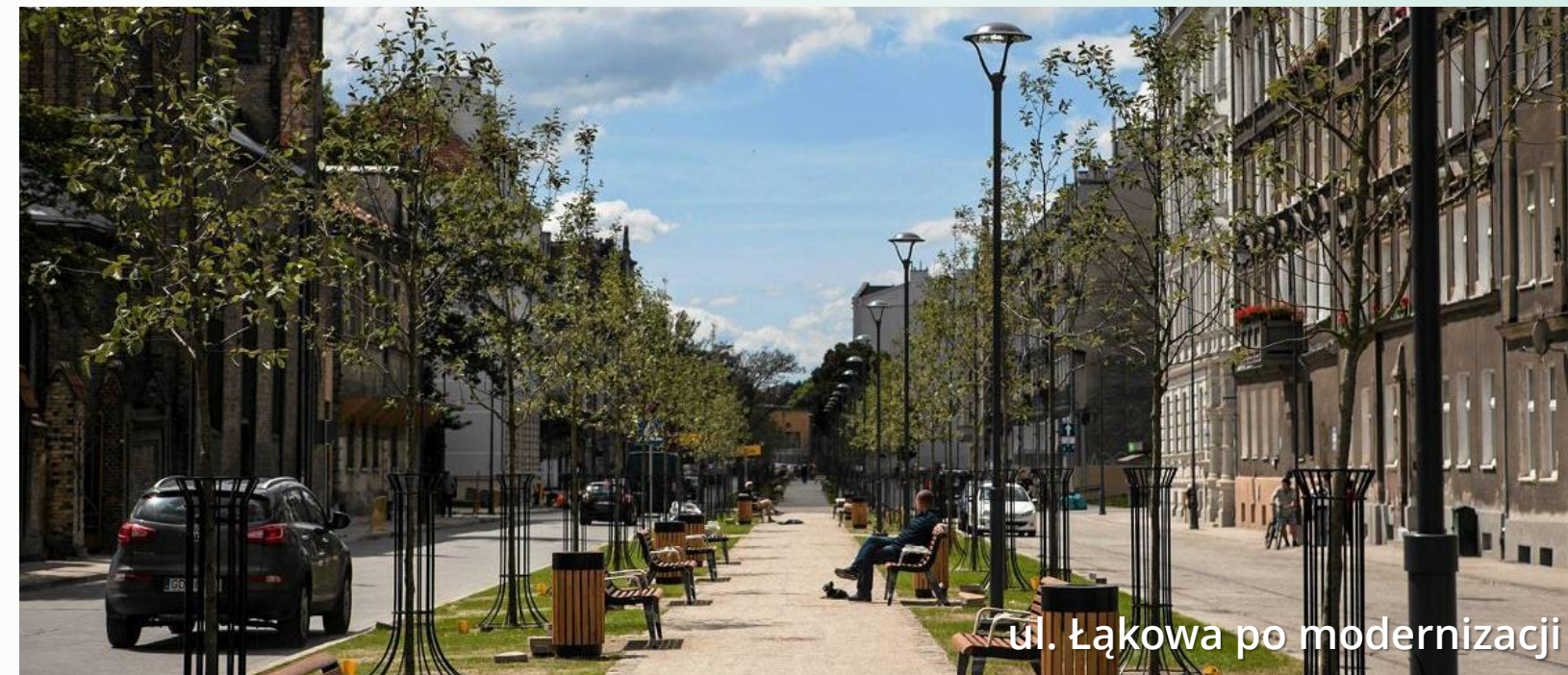
wyremontowane fronty kamienic
