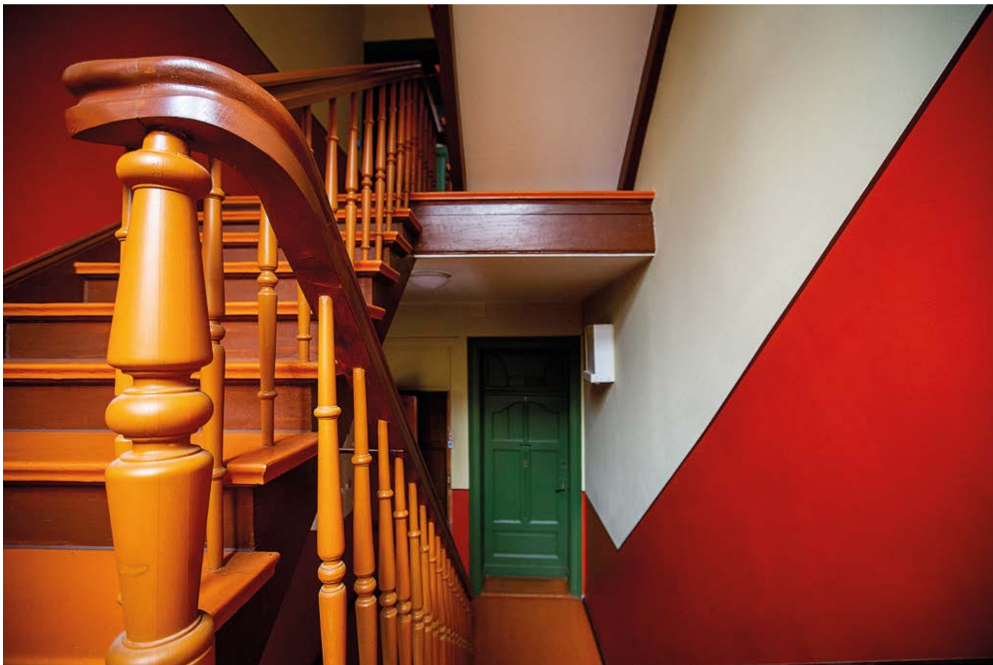
Malbork, ul. Mickiewicza 36, klatka schodowa
