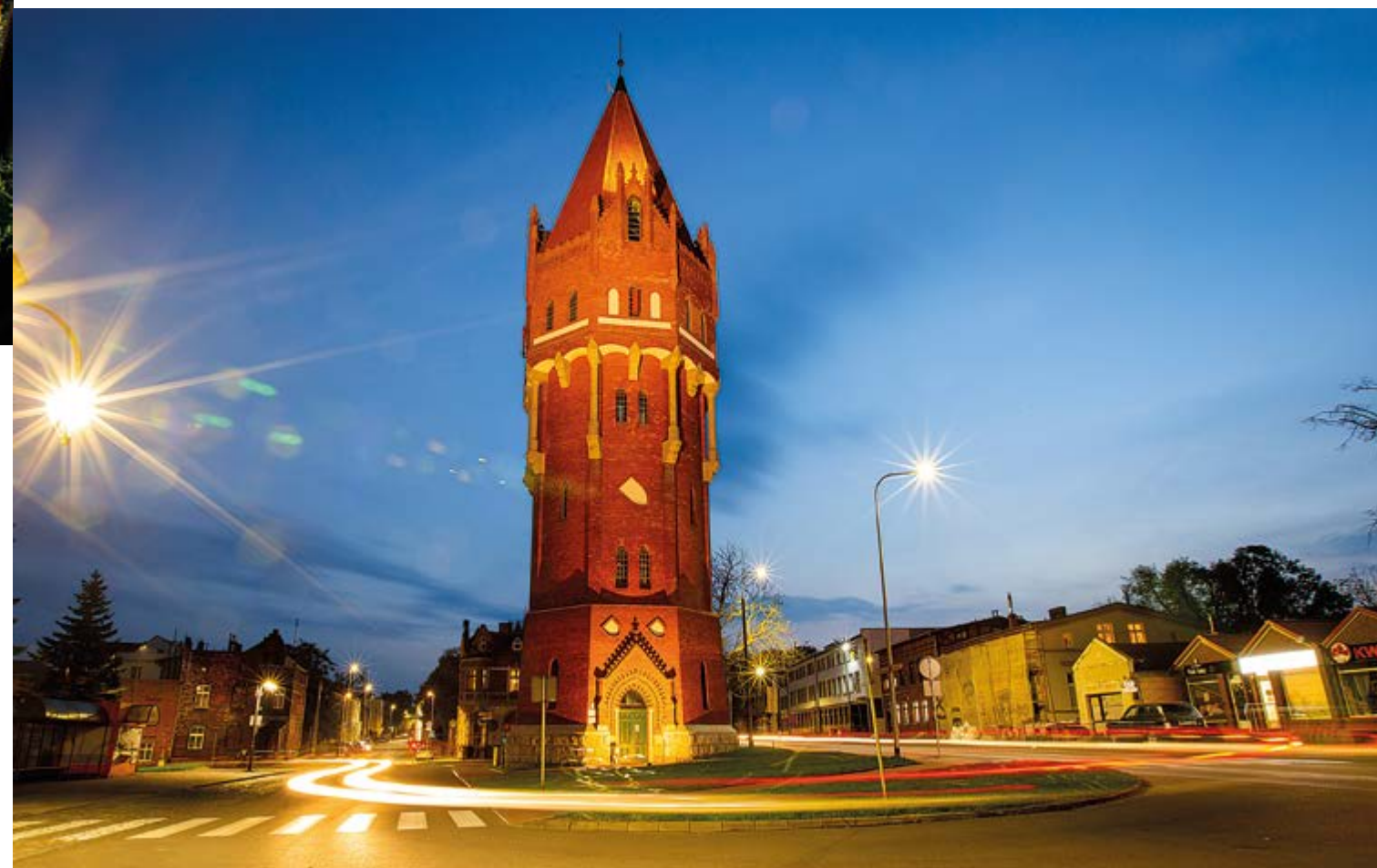
Malbork, wieża ciśnieni – zbiornik
