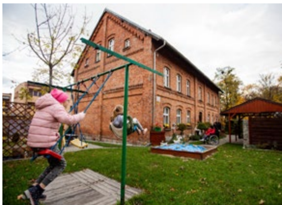
Fot. 19 Budynki przy ulicy 1 maja 58 w Rybniku (fot. I. Dziuk, archiwum NID)
