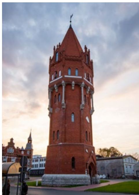
Fot. 27b Placówka wsparcia dziennego w Wieży Ciśnień w Malborku (fot. I. Dziuk, archiwum NID)
