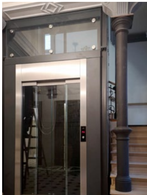
Fot. 54b Żyrardów, winda w duszy schodów zabytkowych, budynek Kantoru (fot. M. Badeńska-Stapp, archiwum autorki)
