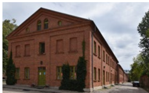
Fot. 36a Domy na osiedlu robotniczym Księży Młyn w Łodzi, po remoncie (fot. A. Lorenc-Karczewska, archiwum NID)
