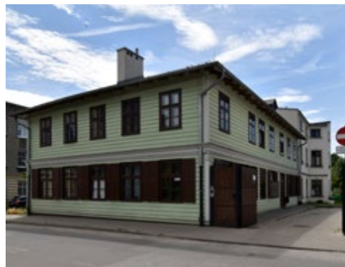
Fot. 38 Narożny budynek drewniany, zespół domów przy ul. Przędzalnianej 91 w Łodzi, po remoncie (fot. A. Lorenc-Karczewska, archiwum NID)
